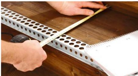
Stufenmaß mithilfe eines Maßbandes/Zollstocks aufnehmen, auf Stufelement übertragen und anschließend zusägen.
