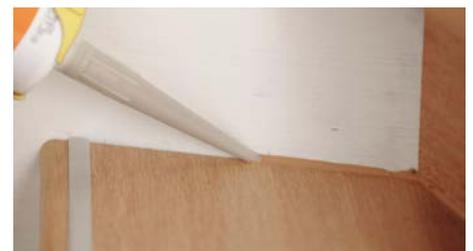
Nach der Montage der Treppe wird mit dem passenden moderna Fugendichtstoff versiegelt.
