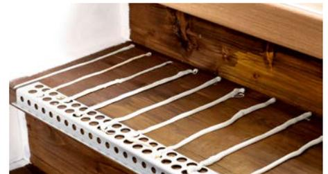
Montagekleber parallel zur Laufrichtung auftragen.
