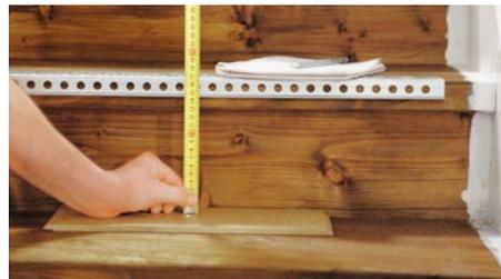
Ausmessen der Setzstufe mithilfe eines Trittsufenmusters. Maße auf Setzstufelement übertragen und anschließend zusägen.
