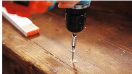
Tritt- und Setzstufe miteinander verschrauben, um Treppenknarren zu reduzieren. Es werden 3 bis 5 Fixierungen empfohlen.
