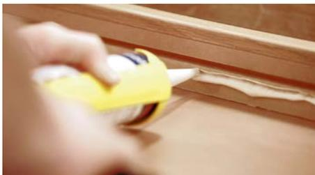
Montagekleber großzügig auf der Innenseite der Vorderkante des Stufelements auftragen.
